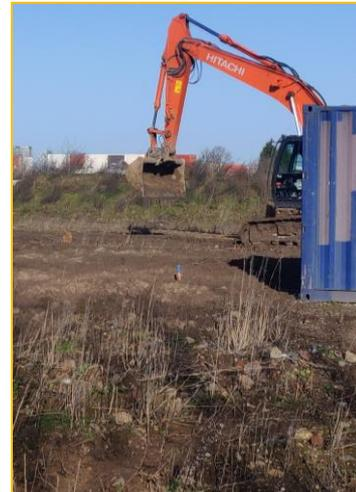
Figure 29. Photographies de la réalisation d'un prélèvement et d'un recompactage à la pelle mécanique
