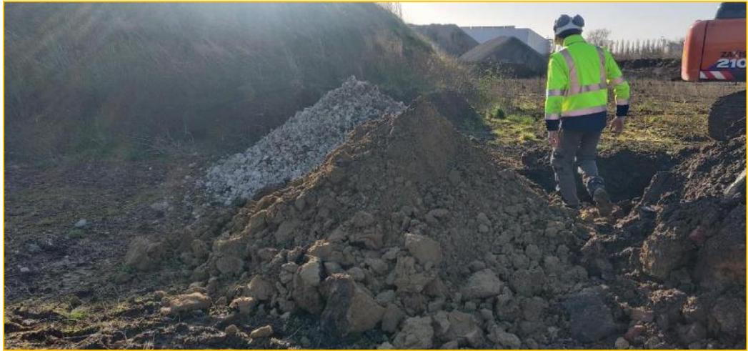
Figure 28. Prélèvement des terrains jusque 3,0 m de profondeur
