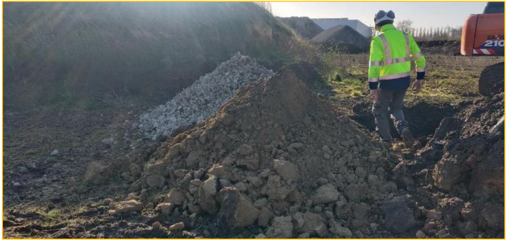
Figure 28. Prélèvement des terrains jusque 3,0 m de profondeur
