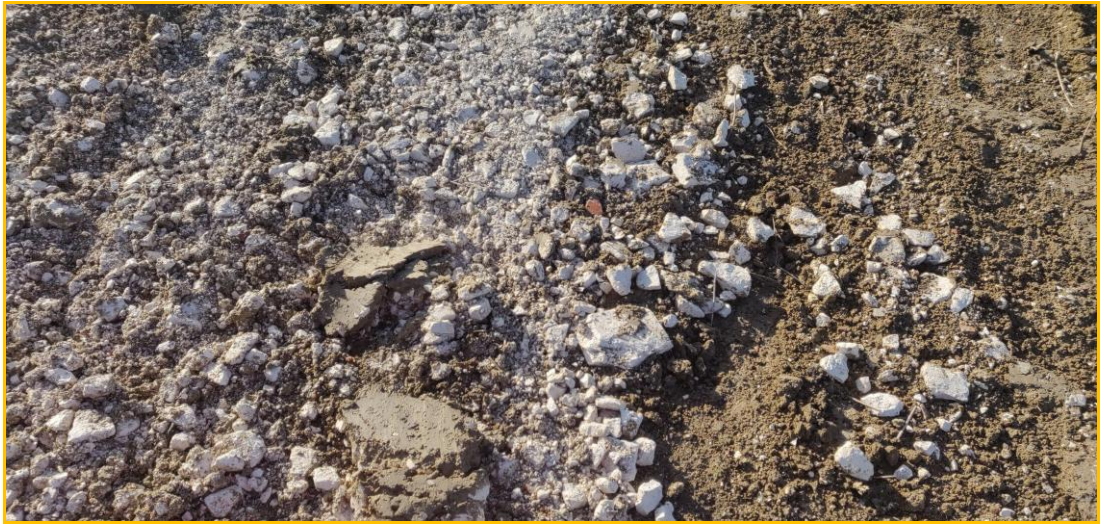
Figure 31. Photographie d'un rebouchage et compactage sommaire d'un sondage à la pelle mécanique descendu à 6,0 m de profondeur
