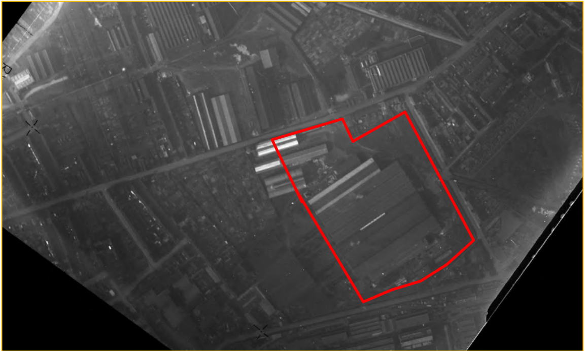
Figure 15. Vue aérienne du site datant d'août 1932 (Remonter le temps)
