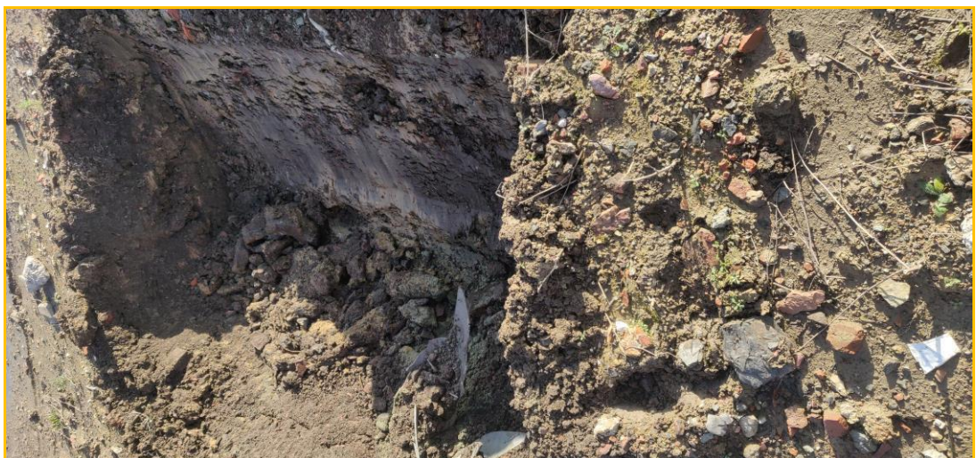
Figure 30. Photographie d'un sondage recompacté à 1,0 m de profondeur
