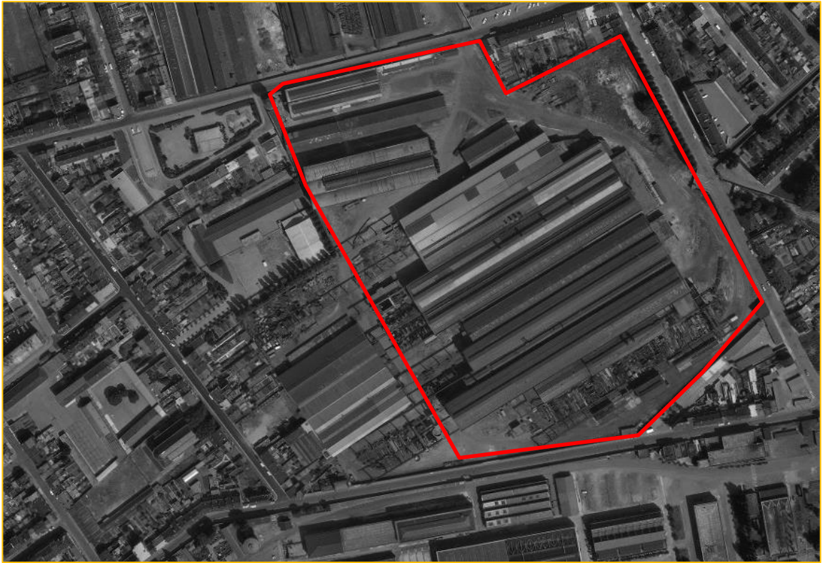
Figure 17. Vue aérienne du site datant de janvier 1971 (Remonter le temps)
