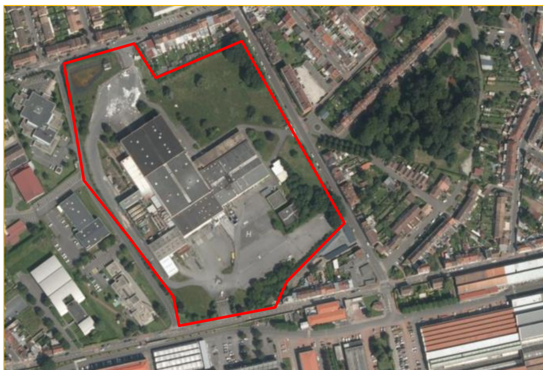
Figure 22. Vue aérienne du site datant d'août 2012 (Remonter le temps)
