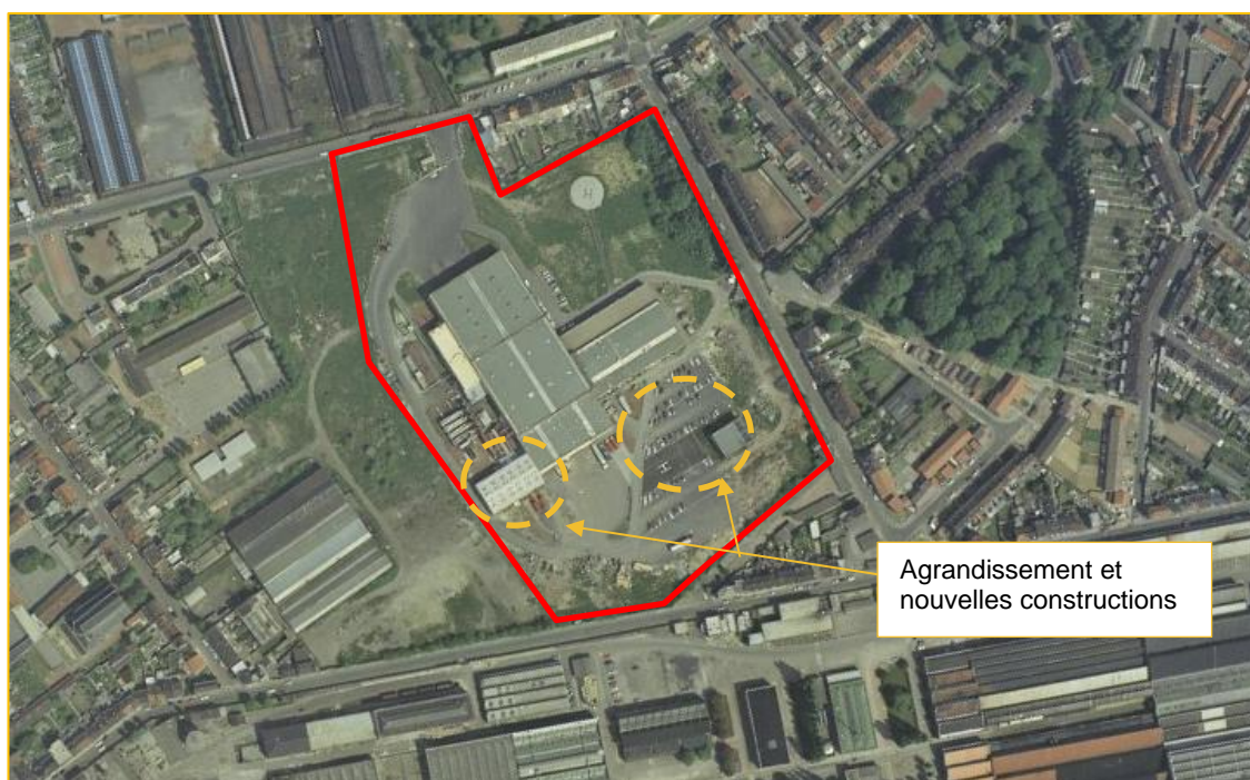
Figure 20. Vue aérienne du site datant de juin 1985 (Remonter le temps)
